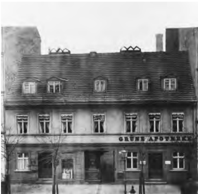
Scherings Grüne Apotheke in der Chausseestraße, Keimzelle der Schering AG. Aufnahme vor dem Abbruch und Neubau im Jahre 1892 (Quelle: SBB-PK, Kartenabteilung)
