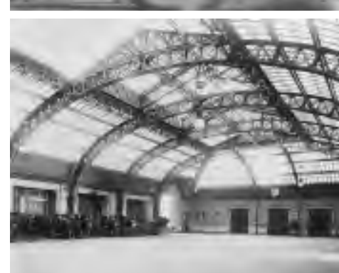
Der „Neue Marstall“ am Schlossplatz. Ansichtenfolge mit Aufnahmen nach der Fertigstellung im Mai 1901 (Quelle: SBB-PK, Kartenabteilung)
